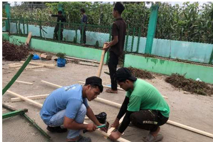
Gambar 6: Pemasangan Fasilitas Pendukung
